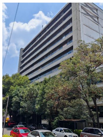
FOTO DE LA FACHADA
